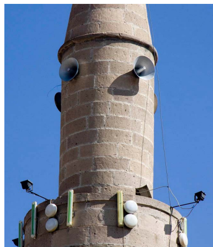
Schon lange ruft der Muezzin nicht mehr selbst. Die Schallpegel der Druckkammerlautsprecher würde er nie erreichen.
